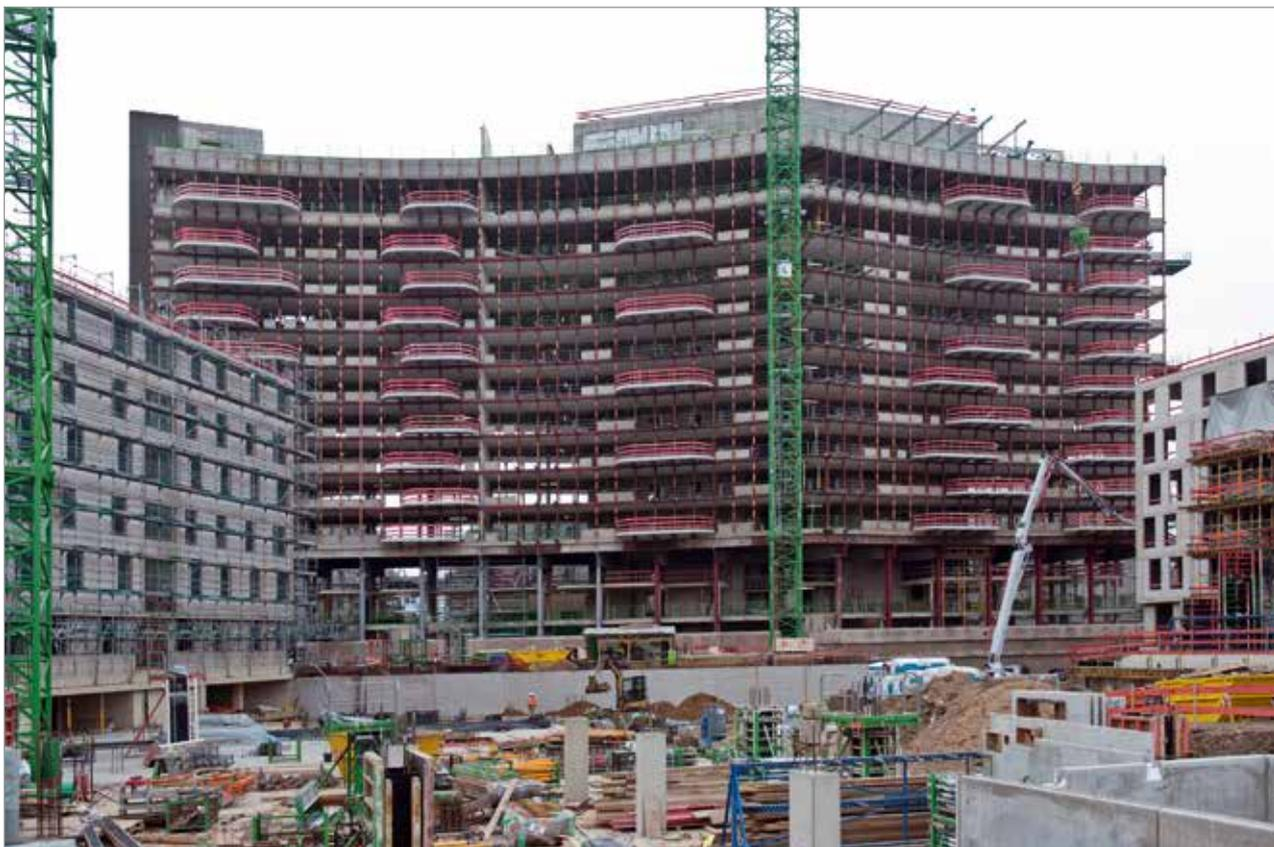
Abb. 2: Die freigelegten, durchgehenden senkrechten Stahlträger des tragenden Stahlskeletts konnten nach dem Entfernen der geschwungenen Hochhausscheibe für die Montage der Balkone genutzt werden. Sie bestehen aus ca. zwei Meter ausragenden Doppel-T-Trägern mit einem aufliegenden Betonfertigteil in Sichtbetonqualität. ©Schöck
