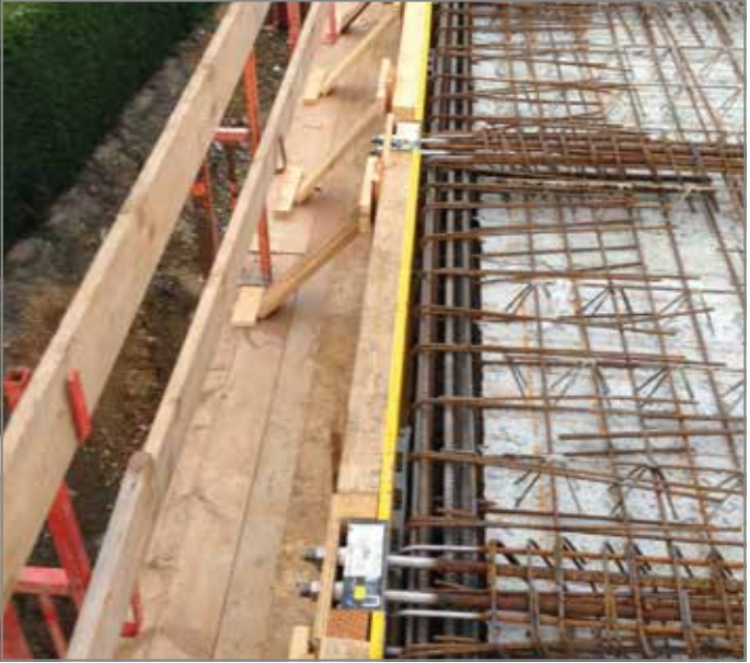
Abb. 25: Verwendung der optionalen Einbauhilfe von Schöck beim Einsatz in Verbindung mit Wärmedämmverbundsystem. Ansicht zeigt Befestigung an der Deckenrandschalung
