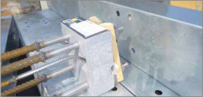
Abb. 27: Verwendung einer Alu-Schalungshilfe
