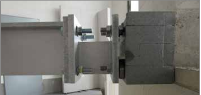
Abb. 33: Einbau eines optionalen bauseitigen Adapters
