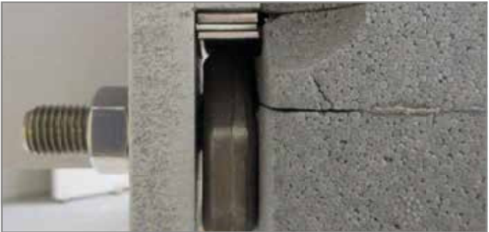
Abb. 35: Auflegen der Stahlkonstruktion mit den am Produkt angebrachten Unterlegplättchen zum Höhenausgleich
