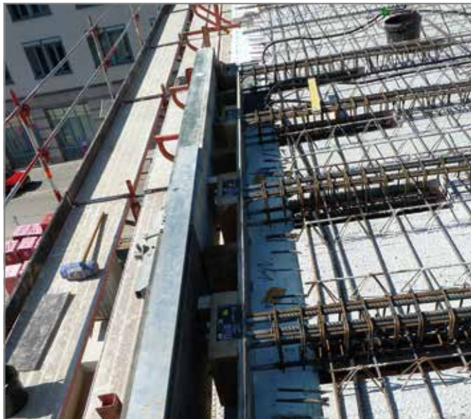
Abb. 30: Bauseitige Bewehrung (Bügel und Übergreifungsbewehrung) beim Einsatz des Schöck Isokorb® T Typ SK-MM2-VV1
