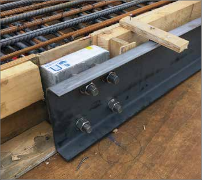
Abb. 29: Verwendung einer Stahl-Schalungshilfe
