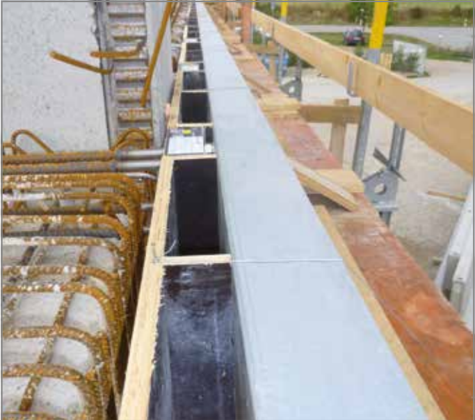
Abb. 28: Alu-Schalungshilfe in eingebautem Zustand
