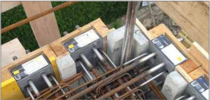
Abb. 31: Einbau bei Außenecken
