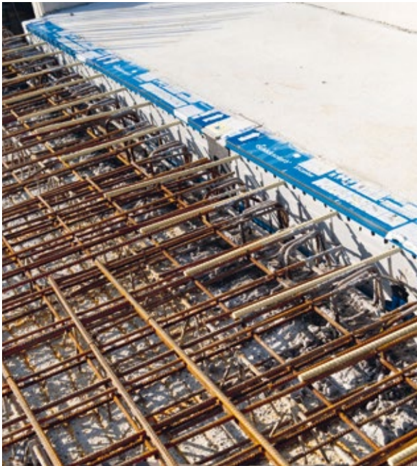
Montage des Fertigteilbalkons auf der Baustelle.
