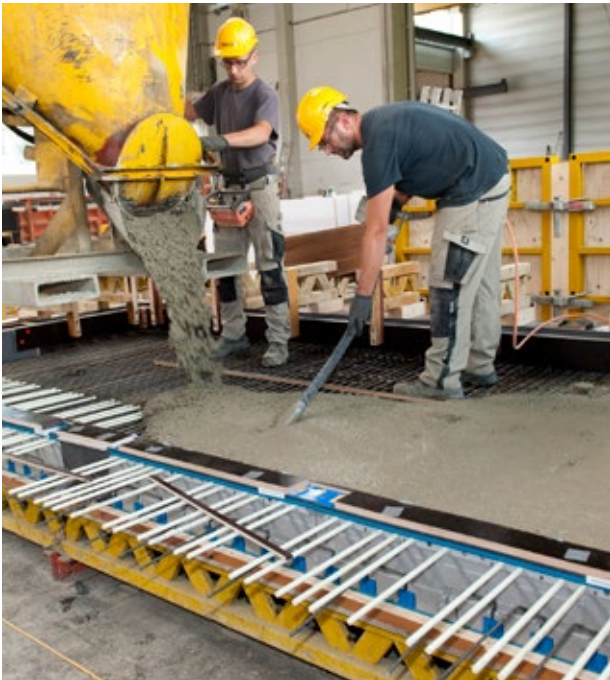
Verarbeitung des Schöck Isokorb® CXT im Fertigteilwerk.
