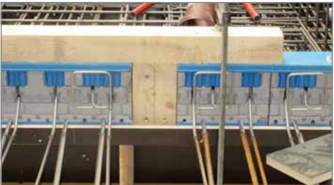
Abb. 17: Aussparung für Abhebeanker
