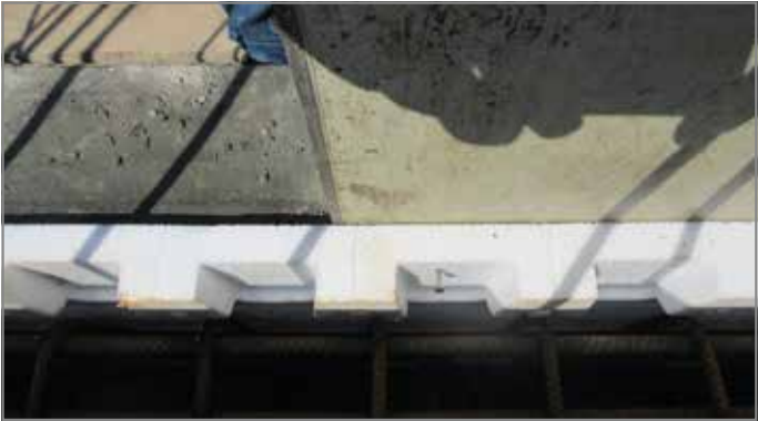
Abb. 42: Detailansicht: Randelemente an Ortbetonschalung anheften
