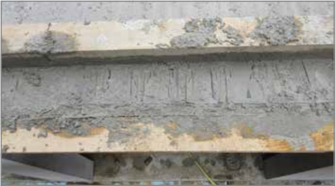
Abb. 38: Überschüssigen Beton entfernen
