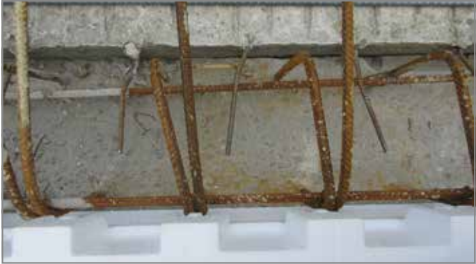
Abb. 27: Raster von Verbügelung und Randelement
