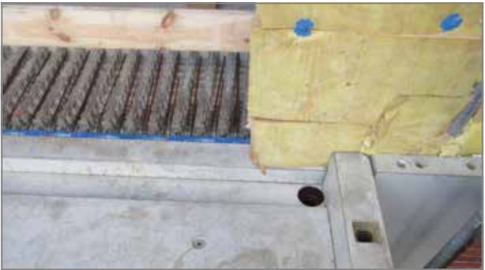
Abb. 63: Fertigteilplatten sauber in den Deckenaussparungen platziert; Balkonsicht
