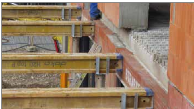
Abb. 44: Mauerwerk über ausgeschalteten Aussparungen
