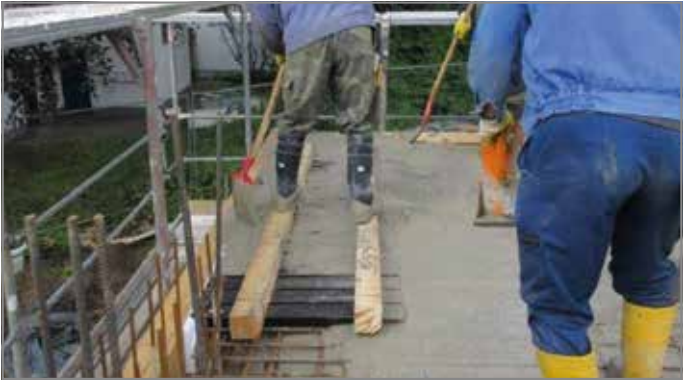
Abb. 36: Fortschreitender Ablauf des Betonierens am Deckenelement
