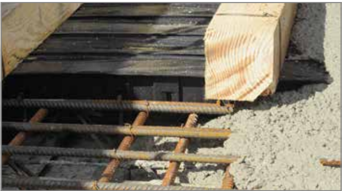
Abb. 35: Detailansicht: Am Schöck IDock® Deckenelement betonieren
