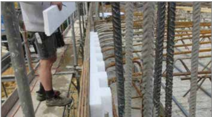
Abb. 24: Randelement auf Maß schneiden und befestigen
