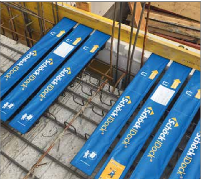
Abb. 30: Deckenelement in Position bringen und auf waagerechten Sitz prüfen
