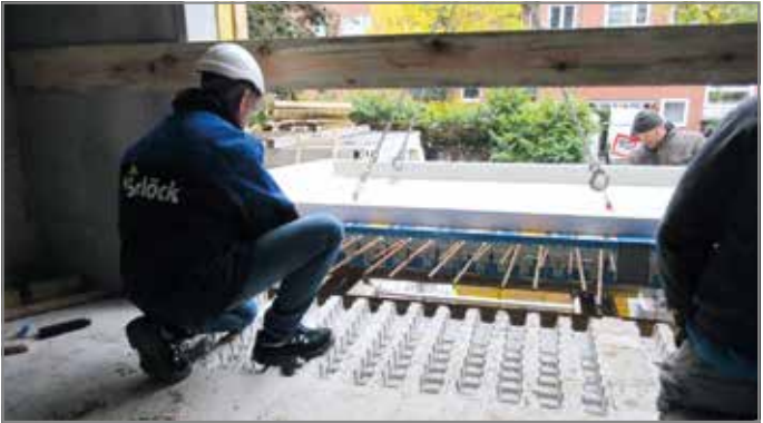
Abb. 62: Fertigteilbalkone in den Deckenaussparungen platzieren
