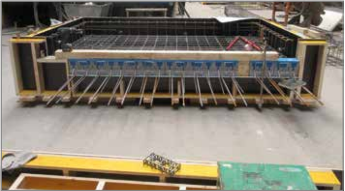
Abb. 15: Schalung, Bewehrung und Schöck Isokorb® ID
