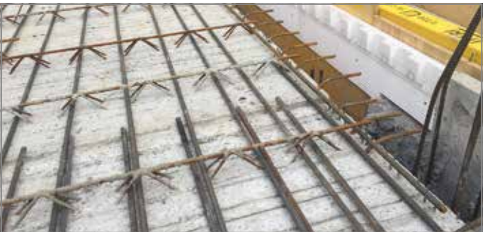
Abb. 41: Randelemente an Ortbetonschalung anheften
