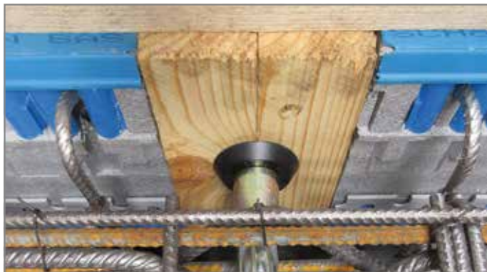
Abb. 18: Detailansicht: Aussparung für Abhebeanker
