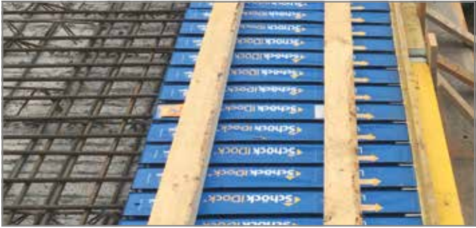
Abb. 31: Deckenelement mit Kanthölzern oder Gerüstbohlen niederhalten
