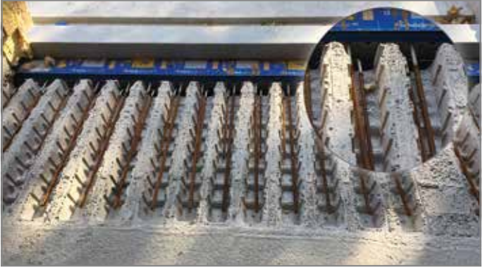
Abb. 64: Fertigteilplatten sauber in den Deckenaussparungen platziert; Deckensicht
