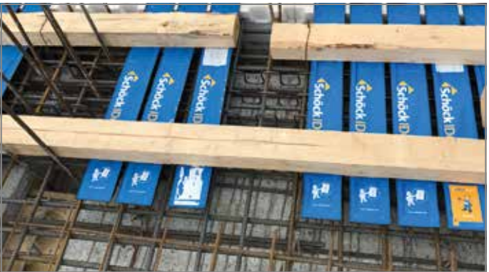
Abb. 26: Korrekte Position der bauseitigen Bewehrung durch Auflegen der Deckenelemente prüfen
