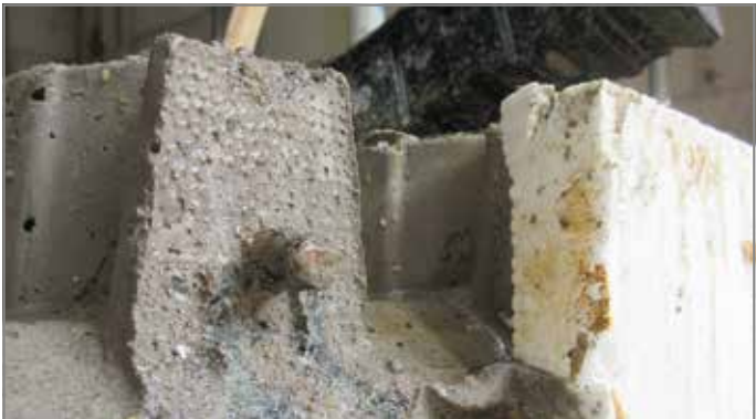
Abb. 47: Detailansicht: Decke nach Entfernung des Schöck IDock® Aussparungselementes
