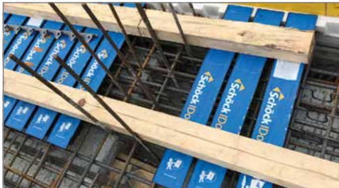
Abb. 33: Decke für das Betonieren vorbereitet
