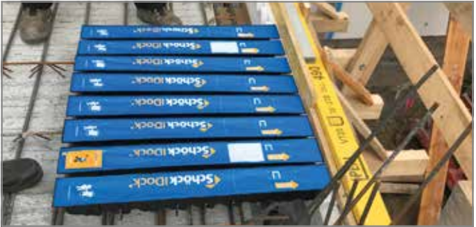
Abb. 29: Deckenelement einsetzen, Bewehrung in Vertiefung der Aussparungselemente hochziehen und ver-rödeln
