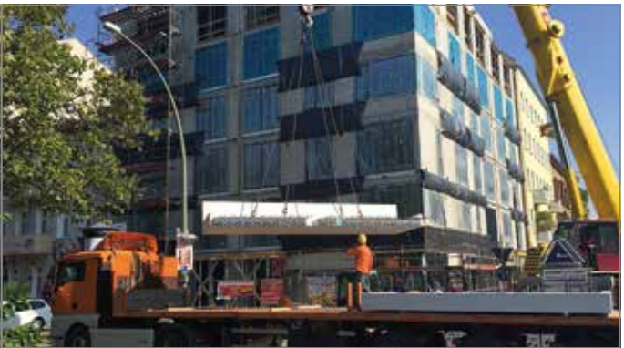
Abb. 61: Anlieferung der Fertigteilbalkone
