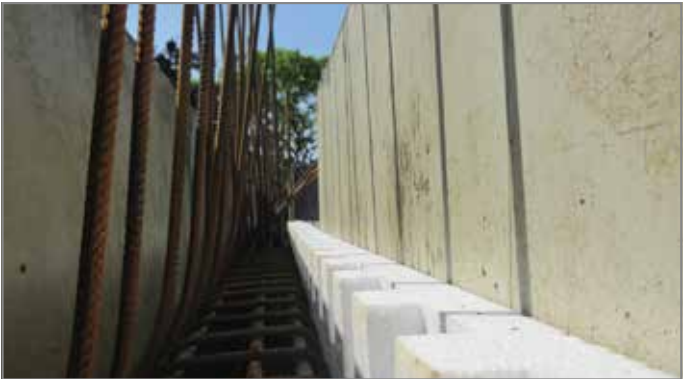
Abb. 43: Randelement an Außenwandschalung befestigt
