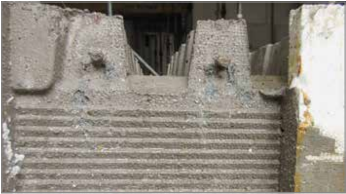
Abb. 46: Decke nach Entfernung des Schöck IDock® Aussparungselementes mit sichtbarer Anschlussbewehrung
