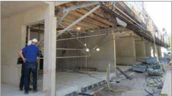
Abb. 52: Gerüst an Decke fixiert; Beispiel
