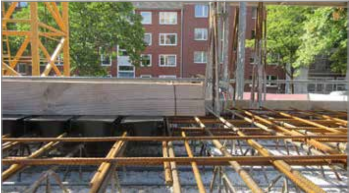
Abb. 32: Ansicht von vorne: Deckenelement mit Kanthölzern oder Gerüstbohlen niederhalten
