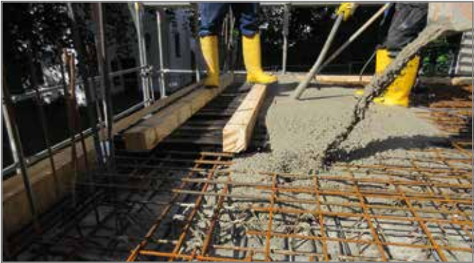
Abb. 34: Am Schöck IDock® Deckenelement betonieren
