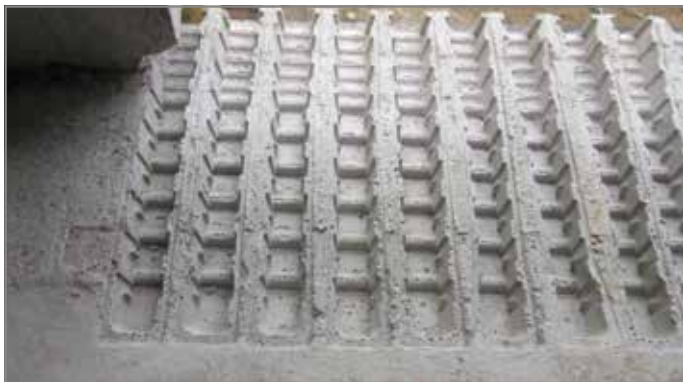
Abb. 48: Decke nach Entfernung des Schöck IDock® Aussparungselementes ohne Schöck Isokorb® ID
