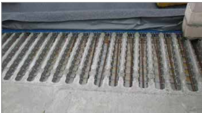
Abb. 49: Decke nach Entfernung des Schöck IDock® Aussparungselementes mit Schöck Isokorb® ID
