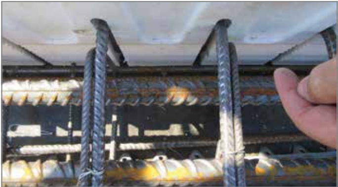
Abb. 28: Quer- und Längsbewehrung verlegen
