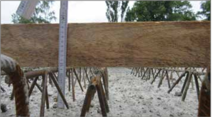
Abb. 25: Höhe der Gitterträger beachten
