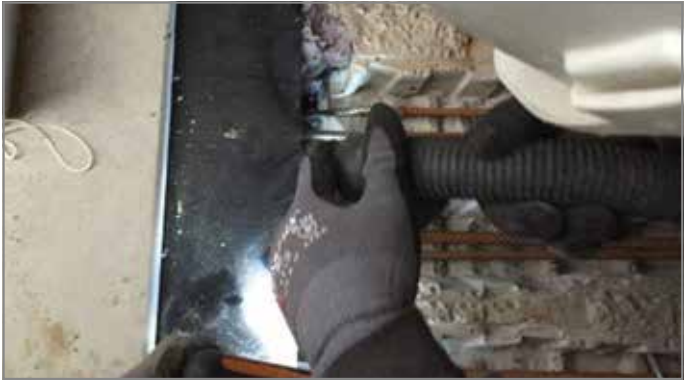
Abb. 54: Vergussbereich abdichten und überschüssiges Material entfernen
