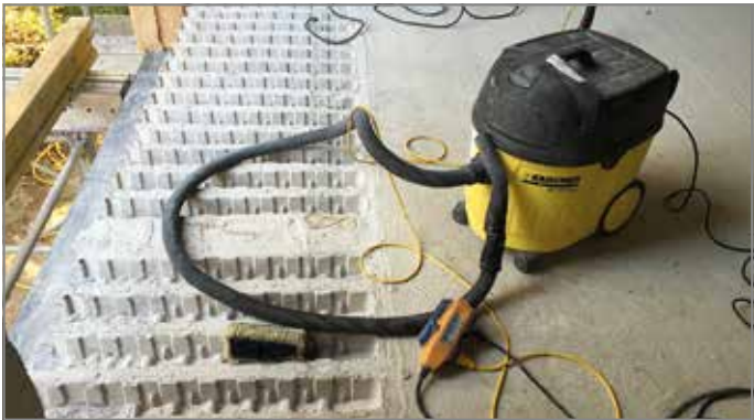
Abb. 50: Aussparung mit Industriestaubsauger reinigen
