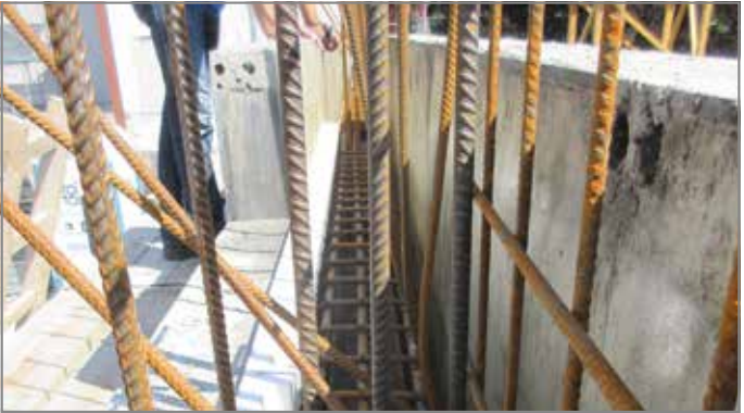
Abb. 40: Bügel vorbereiten
