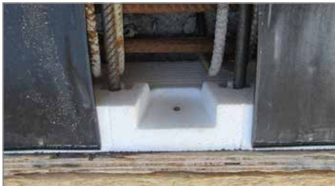
Abb. 19: Auf der Baustelle kann an der Position des Abhebeankers auf ein Aussparungselement verzichtet werden
