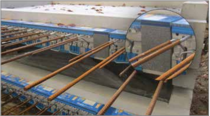
Abb. 20: Aussparung mit Abhebeancker nach Transport mit Schöck Isokorb® Typ Z/ZXT verfüllt
