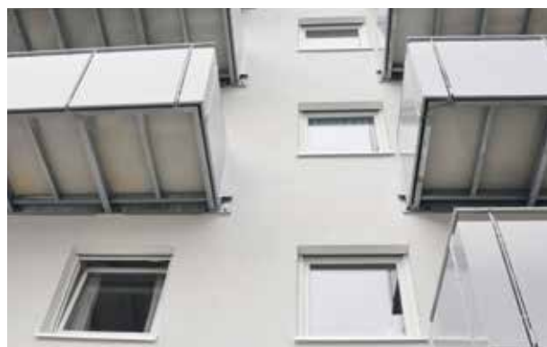
Neue Balkone für das Stuttgarter Mehrfamilienhaus
