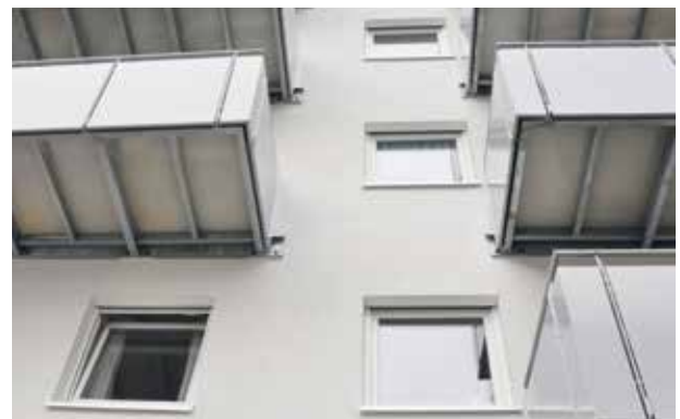
Neue Balkone für das Stuttgarter Mehrfamilienhaus
