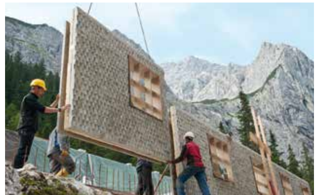
Die vorgefertigten Elementwände mit Schöck Isolink®
