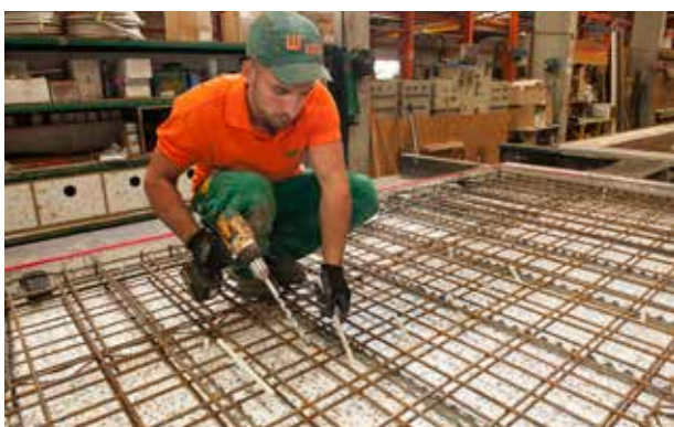
Gegebenenfalls Diagonalstäbe einsetzen (Schöck Isolink® Typ TA-DC).
