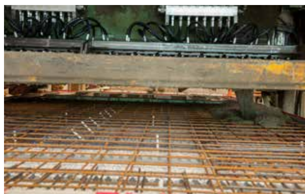
Tragschale betonieren.
