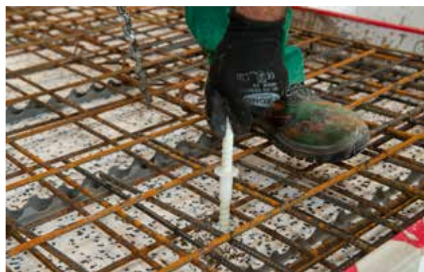
Schöck Isolink® Typ TA-HC in die vorgebohrte Wärmedämmschicht einstecken.
