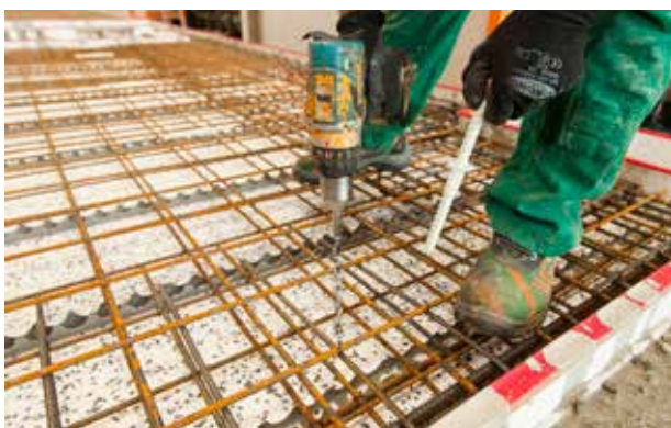
Löcher in Dämmung vordrehen.
