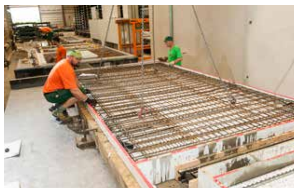
Bewehrung für Tragschale installieren.
