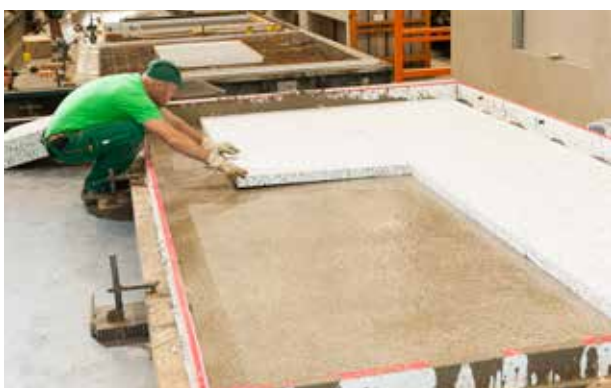
Frisch betonierte Vorsatzschale mit Wärmedämmplatten belegen.
