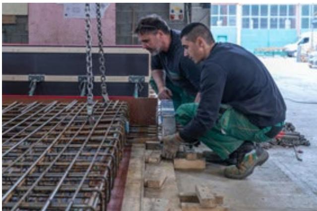
*Mit dem weiterentwickelten Isokorb für den Höhenversatz lassen sich Halb- und Vollfertigteilplatten im Fertigteilwerk nun auch ohne Sonderkonstruktionen herstellen. Die kompakte Konstruktion ermöglicht die liegende Schalung auf einem Schaltisch ohne Unterbau. Bild: Schöck Bauteile GmbH, Abdruck honorarfrei.*
