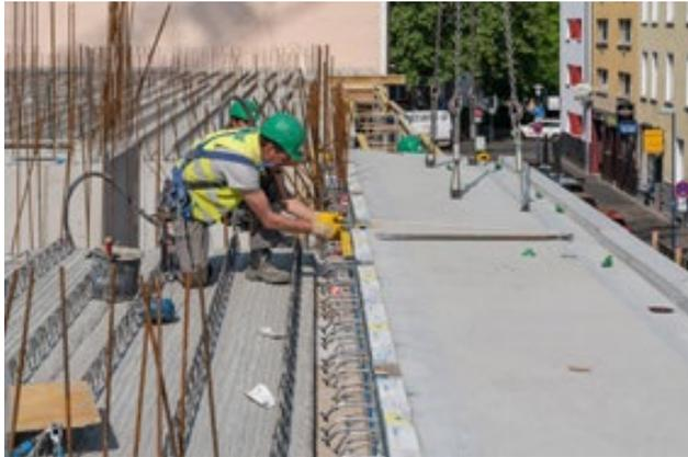
*Der weiterentwickelte Isokorb für den Höhenversatz zeichnet sich durch ein reduziertes Gewicht aus. Beim Einbau sorgt dies für ein leichteres Handling und ermöglicht, je nach Produkttyp, sogar die Ein-Mann-Montage auf der Baustelle oder im Fertigteilwerk. Bild: Schöck Bauteile GmbH, Abdruck honorarfrei.*
