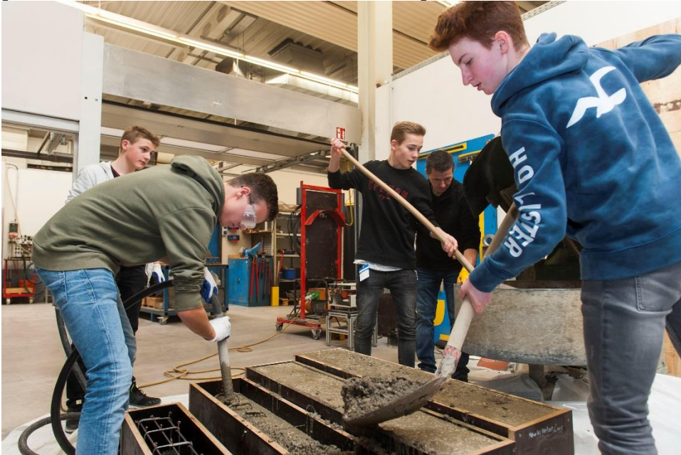
Beim zweiten Praxistag wurden die berechneten Versuchskörper betoniert. (Foto: Schöck Bauteile GmbH, Abdruck honorarfrei.)
