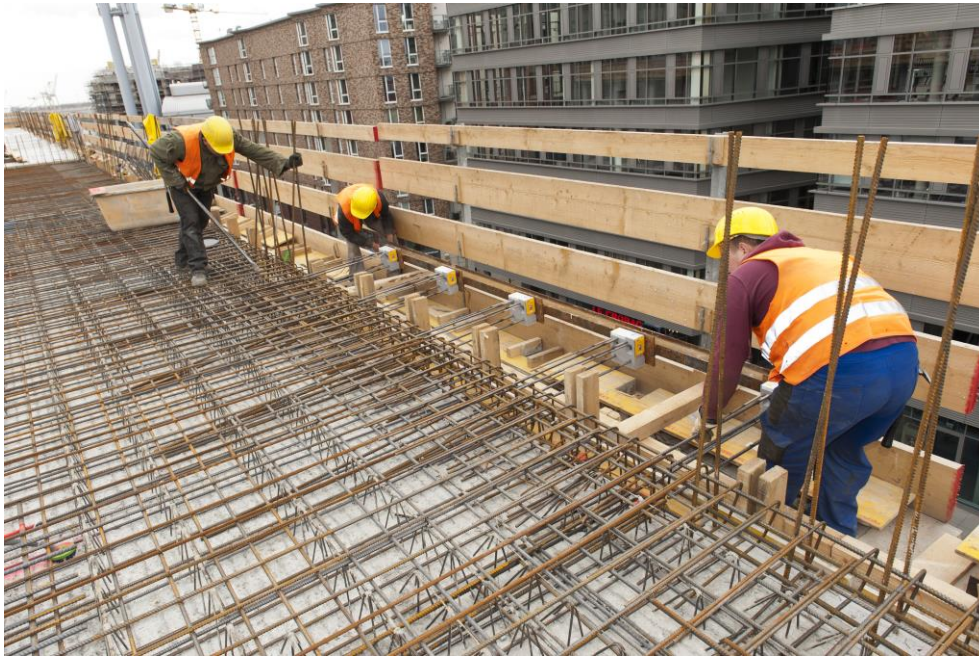
[Einbau Isokorb Typ KS_1.jpg]
