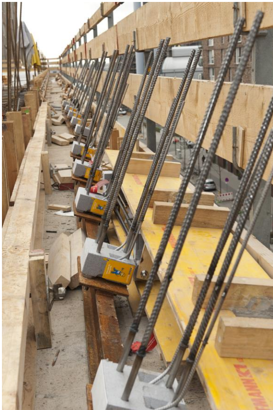
[Einbau Isokorb Typ KS_2.jpg]
