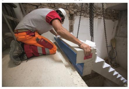
Bei der Entwicklung der Produktreihe wurde ganz besonderen Wert auf den einfachen und schallbrückenfreien Einbau gelegt.
