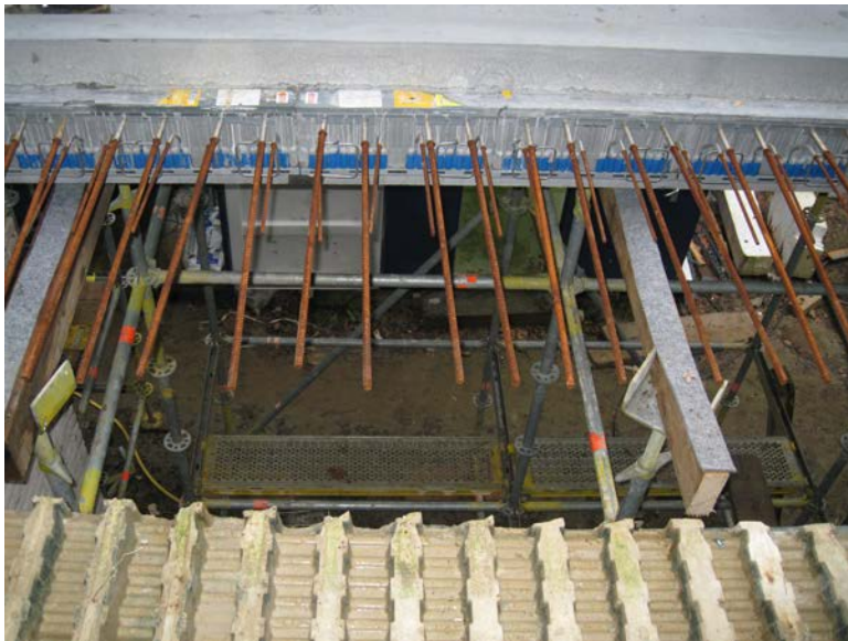
Fertige Balkonplatte mit integriertem Isokorb ID.
