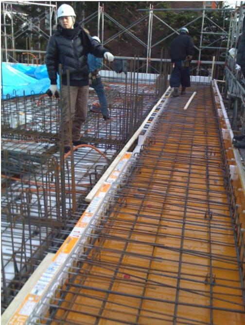
*Durch den Einsatz der Isokorb-Technologie wird die Minimierung der Wärmebrücken an allen auskragenden Bauteilen wie Balkonen, Vordächern, Vorsprüngen und Attiken erreicht. Foto: Schöck Bauteile, Abdruck honorarfrei, Belegexemplar erbeten)*
