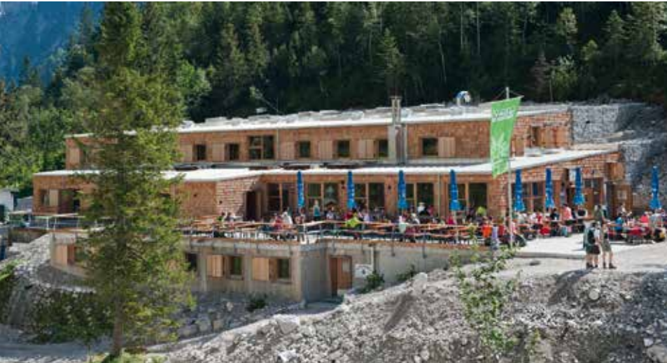
Die Höllentalangerhütte im fertigen Zustand (August 2015)
