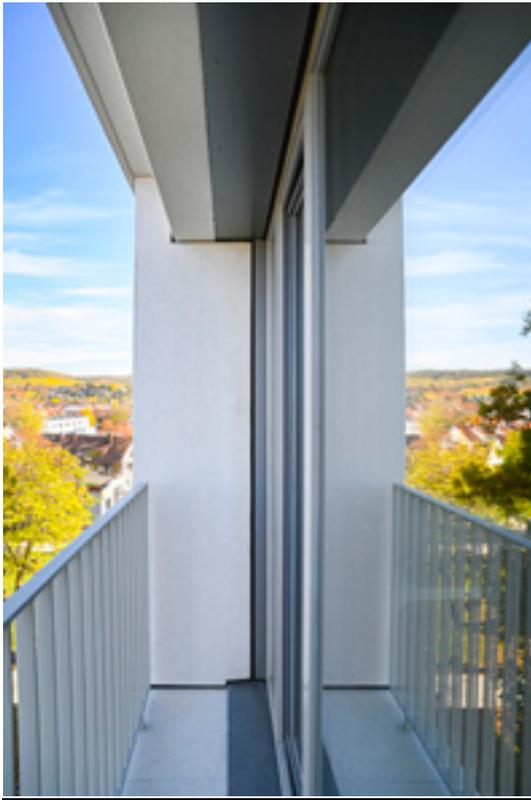
Zur thermischen Trennung der schmalen Gesimselemente, die eine Auskrägung von maximal 70 Zentimeter aufweisen, kam das tragende Wärmedämmelement Schöck Isokorb T Typ K zum Einsatz. Foto: Schöck Bauteile GmbH
