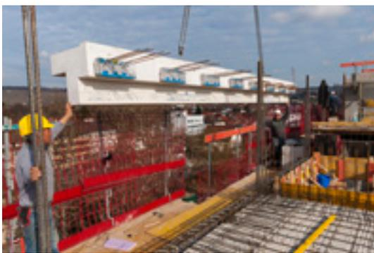
Der Einbau der schmalen Gesimselemente mit dem tragenden Wärmedämmelement Schöck Isokorb T Typ K. Foto: Schöck Bauteile GmbH
