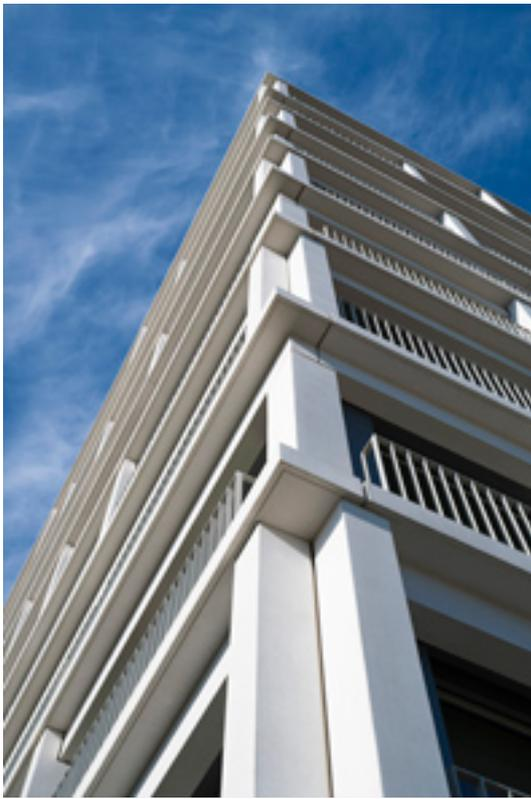
Die bis zu sieben Tonnen schweren Gesimsplatten wurden ebenso wie die Pilaster im Fertigteilwerk in Ebhausen produziert. Der weiße Farbton ist mit Weißzement und aufhellenden Pigmenten aus Titandioxid hergestellt. Foto: Schöck Bauteile GmbH
