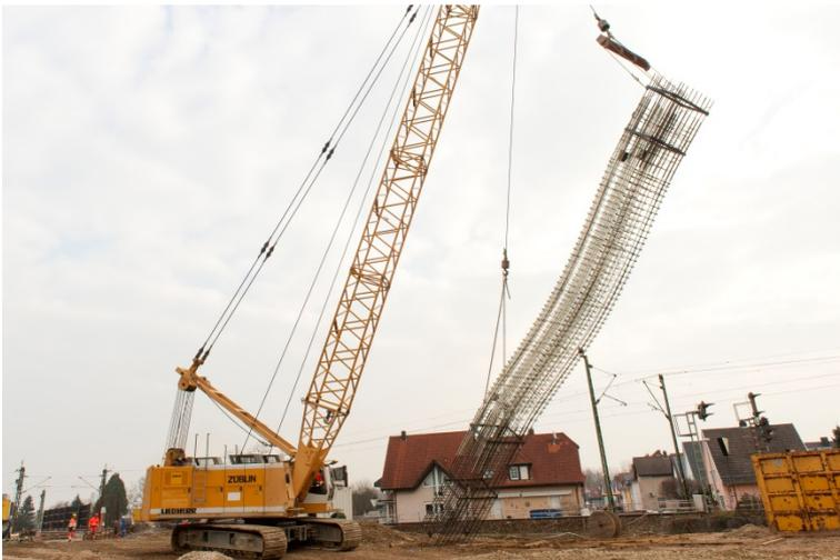
*Aufrichten eines Bewehrungskorbs, bevor er in den Schlitz abgelassen wird. Foto: Schöck Bauteile GmbH, Abdruck honorarfrei.*
