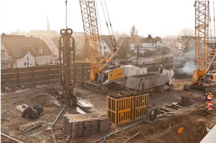
*Aushub einer zirka 40 Meter tiefen Schlitzwandlamelle, in die im Anschluss Bewehrungskörbe eingebaut werden. Foto: Schöck Bauteile GmbH, Abdruck honorarfrei.*
