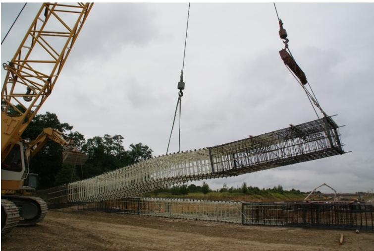
*Im Juli 2015 wird Combar für den Startschacht am Tunnel Rastatt eingebaut. Der Mittelteil des Bewehrungskorbs besteht aus Glasfaserbewehrung, die von der Tunnelvortriebsmaschine einfach durchfahren werden kann. Foto: Schöck Bauteile GmbH, Abdruck honorarfrei.*
