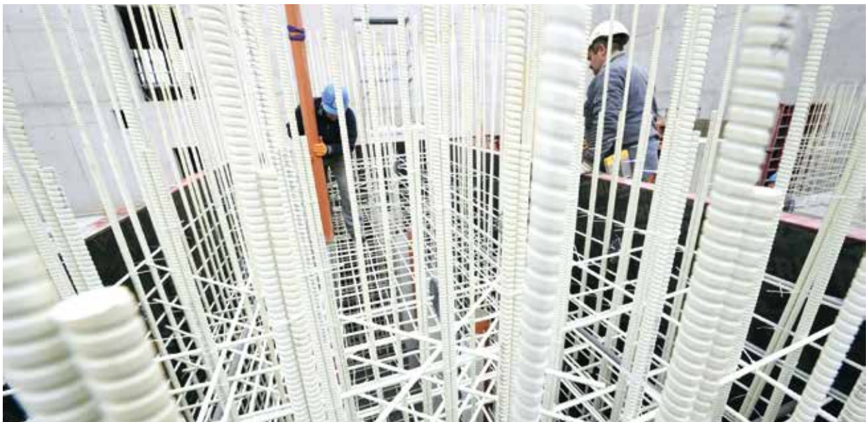
Bereits seit vielen Jahren wird die Spezialbewehrung Schöck Combar® erfolgreich im Ingenieurbau eingesetzt.
