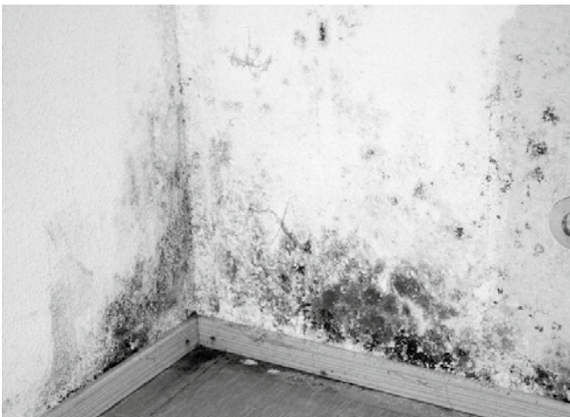
Beispiele für Schimmelpilzbefall im Wärmebrückenbereich.
